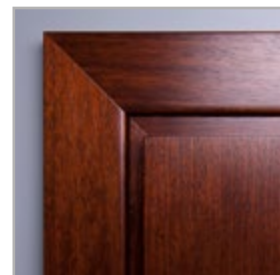
spojování lišt pod úhlem 45°
