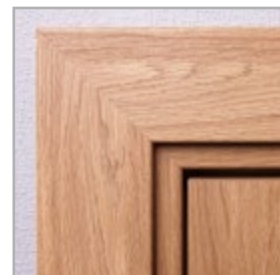
standardní spojování lišt pod úhlem 45°
